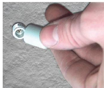
Fatto questo prendiamo un grano e lo avviamo su un dado per il blocco del filo (ATTENZIONE !!!! assicuratevi di inserire bene il grano nell'apposita sede) , a sua volta avviamo il dado sul filo quasi alla sua estremità; inseriamo il filo in un supporto di ancoraggio ed avviamo il tutto al supporto filettato.
